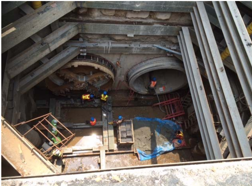
左側：今回到達した掘進機（右側：6月に推進完了した推進管）
